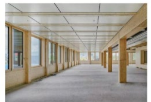
Bild 3 Der Innenraum ist geprägt von Buchenholzbüsten und -balken, kombiniert mit einer hellen Deckenunterseite, darüber verlegt sind das multifunktionale Verbunddeckensystem mit vorkonfigurierten Leitungen für die Haustechnik
