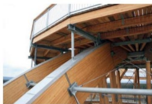
Bild 2 Sämtliche Stahl- und Metallbauteile wurden dauerhaft feuerverzinkt
