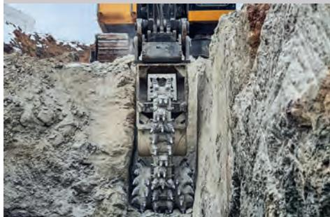
Kettenfräsen von KEMROC sind einzigartige Leistungsträger im Kanal- und Rohrleitungsbau. Sie haben eine mit Hartmetallmeißeln bestückte Fräskette, die zwischen den beiden seitlichen Schneidköpfen umläuft. Damit können sie Gräben in exakt definierter Breite fräsen – ohne den Mittelsteg, der beim Einsatz herkömmlicher Querschneidkopffräsen entsteht und aufwendig entfernt werden muss.
