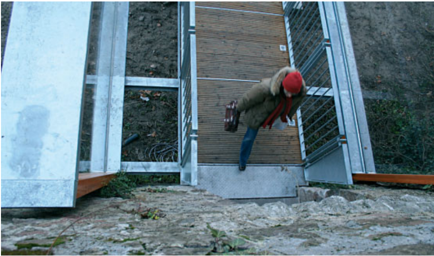
Zwischen Hauptträger und Gehweg, der mit Lärchenbohlen belegt ist, ist 1 m Abstand
