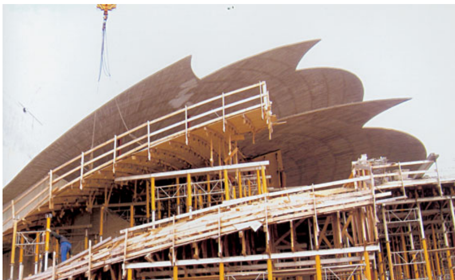
Vorgespannte Dachschalen in Sichtbetonqualität
