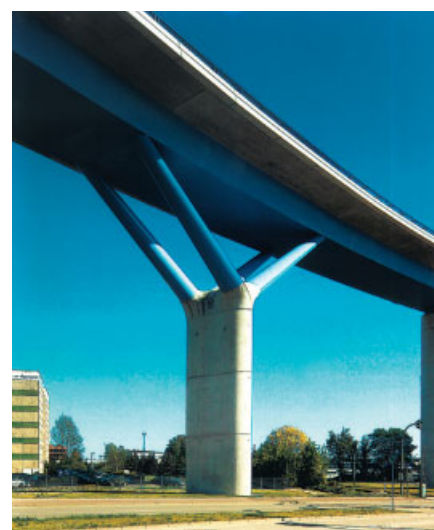
Vorlandbrücke: Die V-förmigen Streben aus Stahl sind biegesteif mit dem Verbundüberbau und dem Stahlbetonpfeiler verbunden
