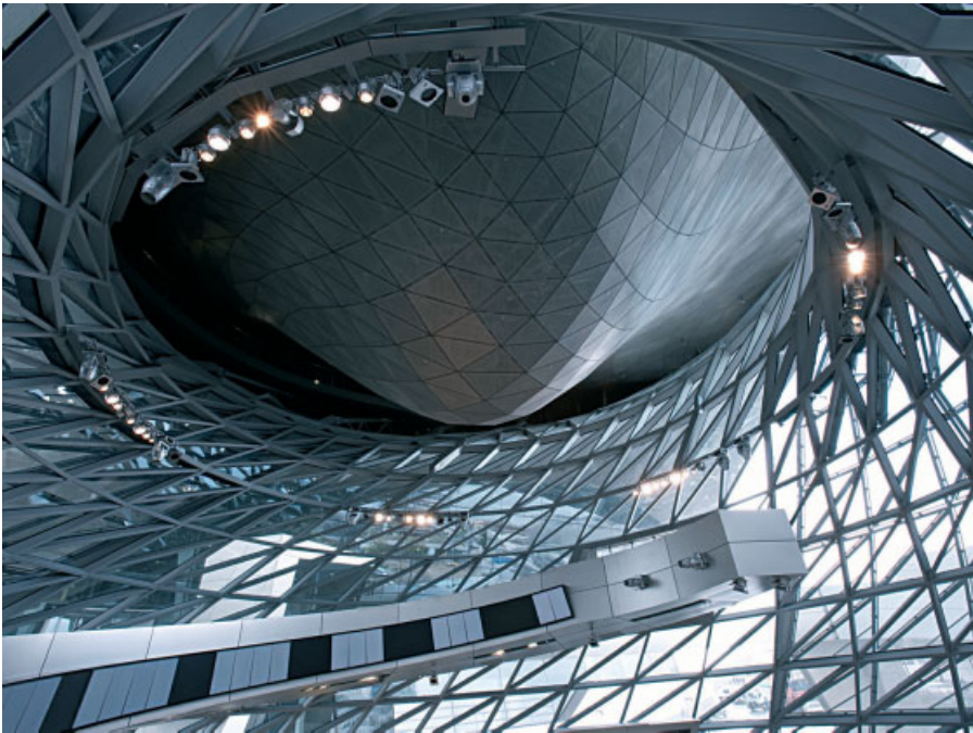
Innenansicht des Doppelkegels aus Stahl und Glas
