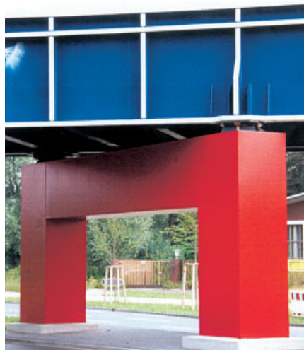
Mittelunterstützung als Rahmen in Stahlbauweise
