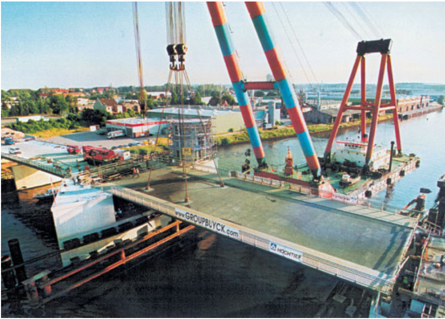
Einhub der Brückenklappe
