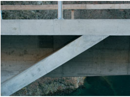
Maximale Höhe an den Knotenpunkten – von dort aus verjüngen sich die Elemente
