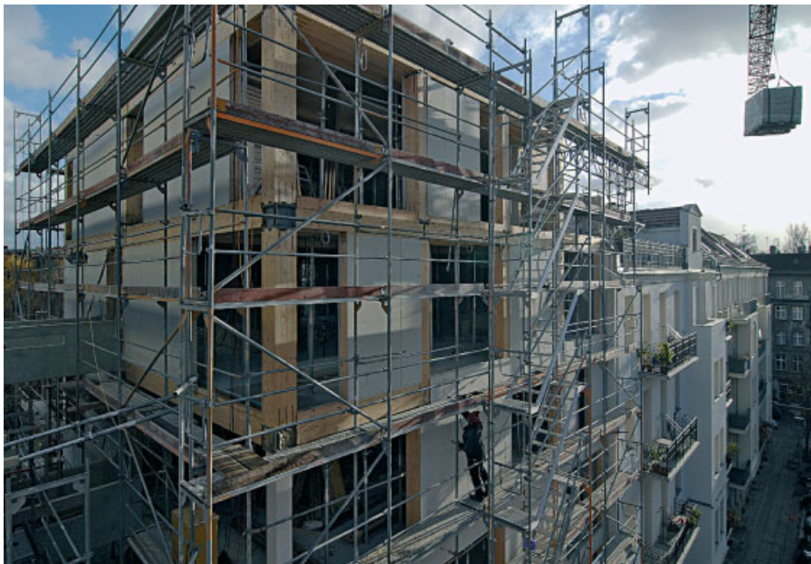
Bild 3. Stützen und Riegel aus Brettschichtholz sind regelmäßig in den Fassaden angeordnet
