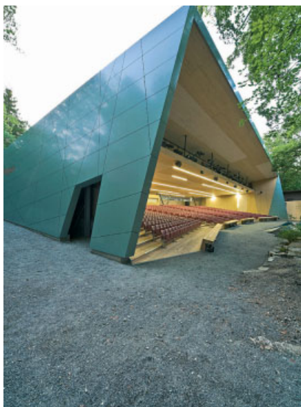
Stützenlose Konstruktion im Sichtfeld der Zuschauer. Die windschiefen Holzständerwände haben hier eine Höhe von 10 m
