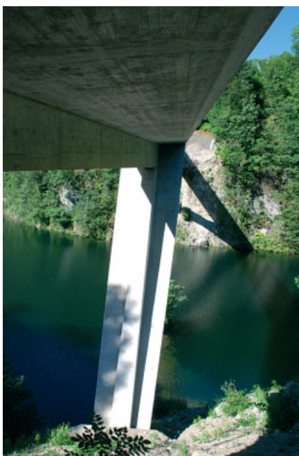
Tragstruktur: Sprengwerk in vorgespanntem Stahlbeton
