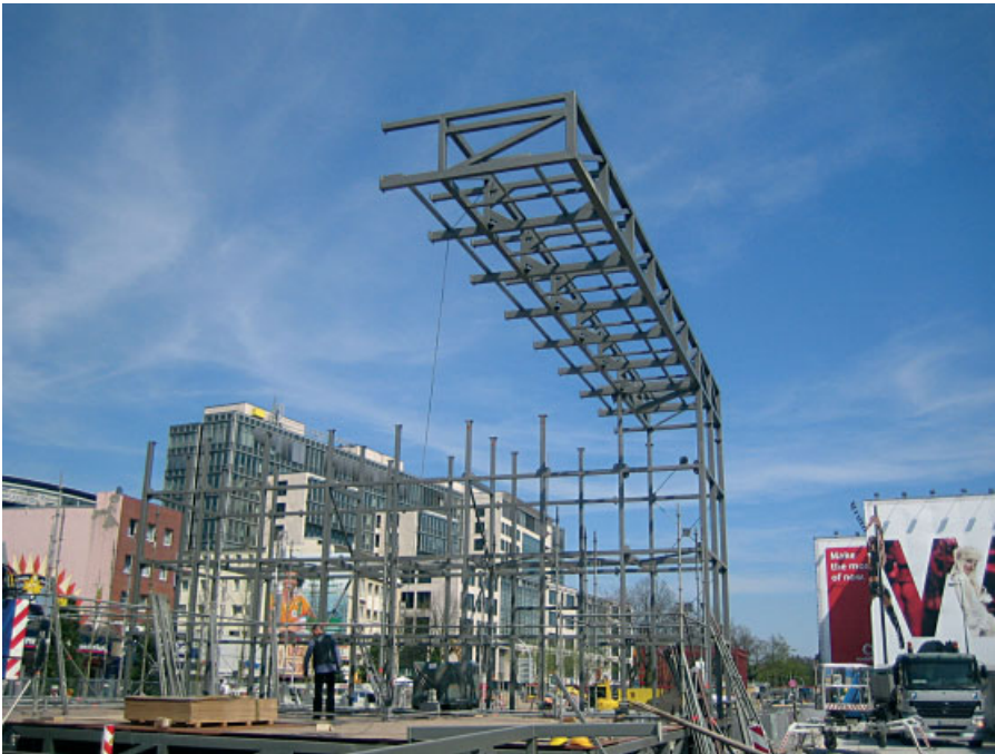
Montage des Trägerrosts mit 12 m Auskragung
