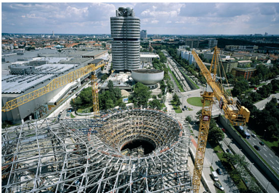
Eine zum Stabwerk aufgelöste Schale bildet das Tragwerk des Doppelkegels, aus dem das Dach entspringt
