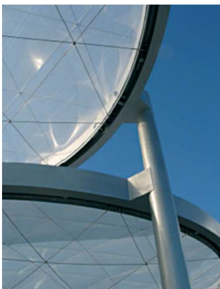
Die Dachhaut aus ETFE-Folie wird durch ein Seilnetz gehalten
