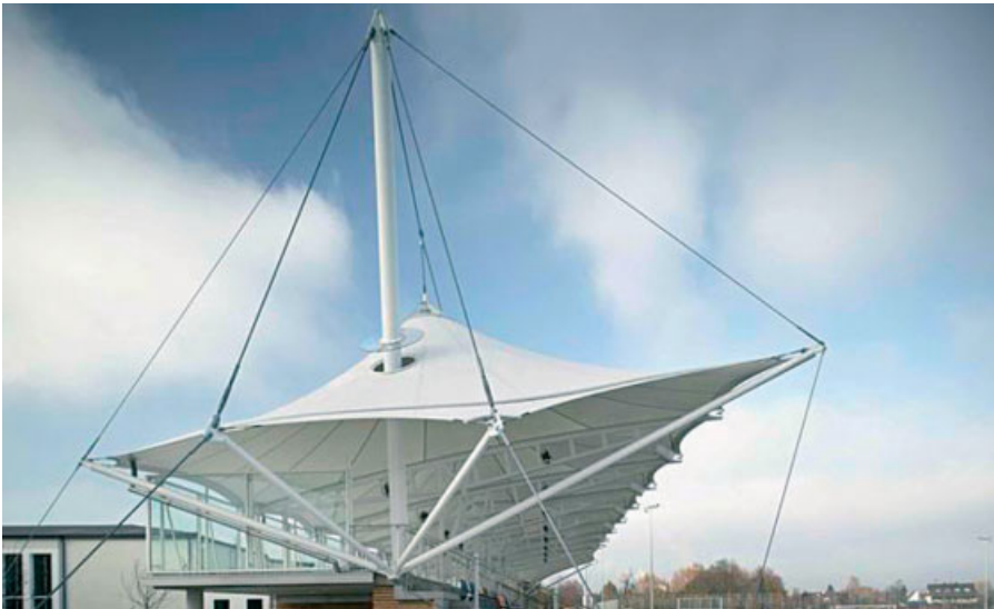
Die seitlichen Endfelder werden durch Seile gehalten, die vom Mastkopf an die Strebenköpfe führen und von dort an Einzelfundamenten gespannt werden
