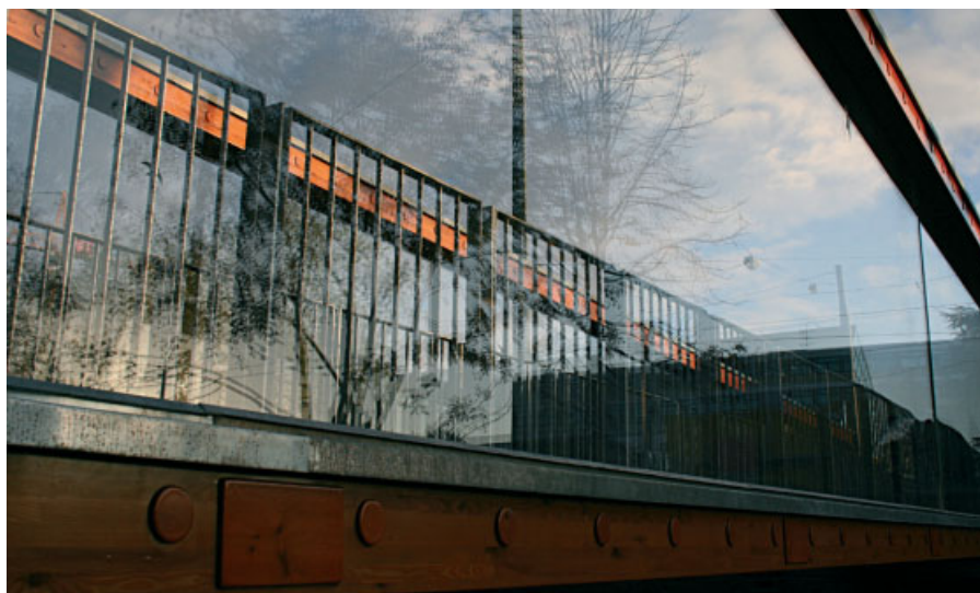
Die PMMA-Scheiben fungieren als Stege zwischen Ober- und Untergurt des filigranen Tragwerks
