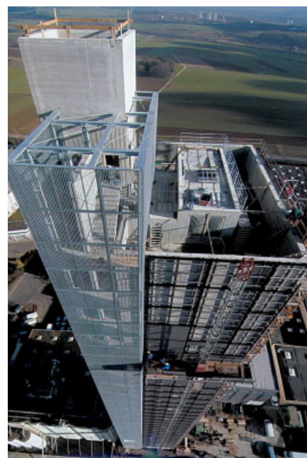
Das angefügte mit Gitterrosten verkleidete Treppenhaus und der höhergezogene Aufzugsschacht geben dem Turm Struktur und Spannung
