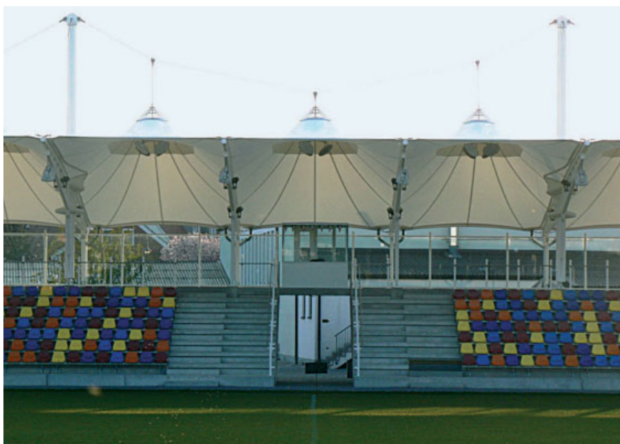
Vier Masten übernehmen mit dem textilen Flachtragwerk die Aussteifung in Längsrichtung
