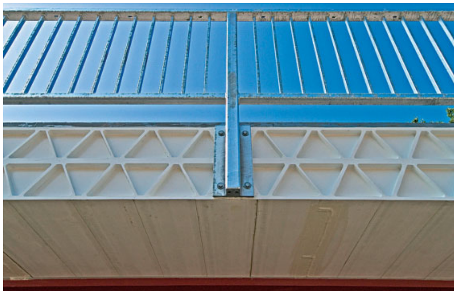
Über Ankerplatten sind die Geländer austauschbar an die Fahrbahnplatte angeschlossen (Fotos: Fiberline Composites A/S, Dänemark)
