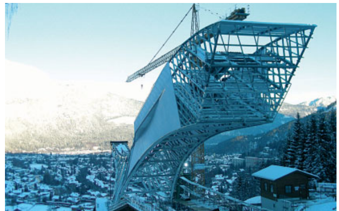
Stahlfachwerkkonstruktion des Anlaufbauwerks
