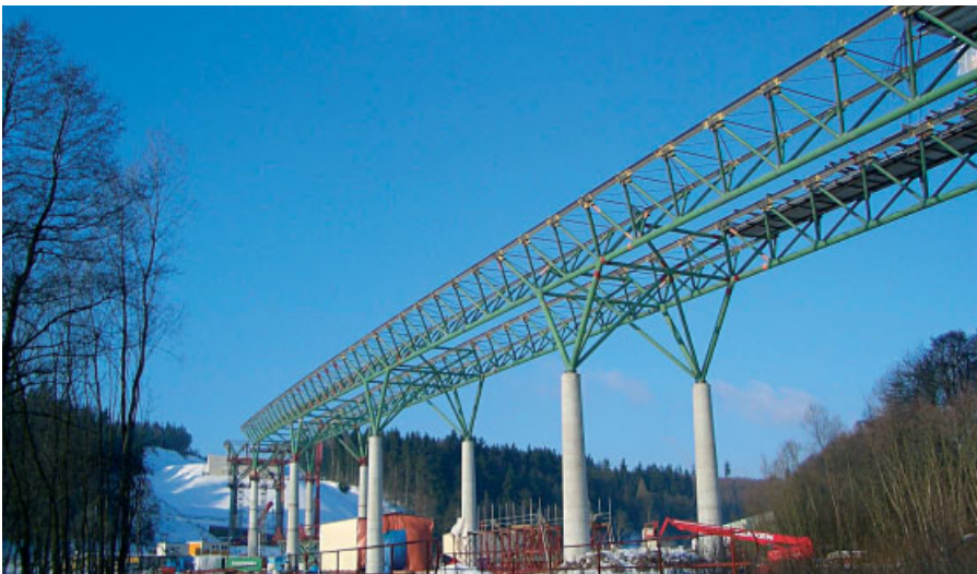
Brückenpfeiler sind schlanke Stahlbeton-Rundsäulen
