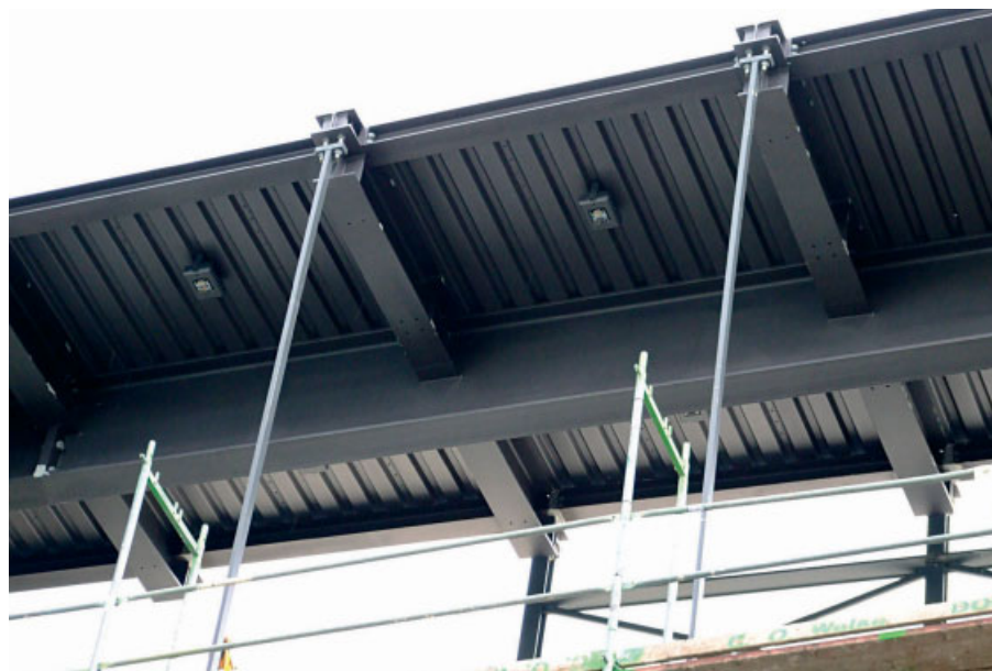
Der Hauptträger im Dach nimmt die angehängten Lasten über Nebenträger auf
