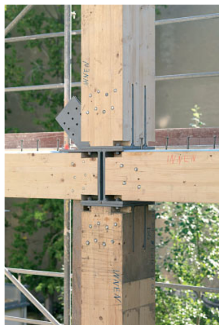
Bild 4. Verbindung Stütze – Riegel
