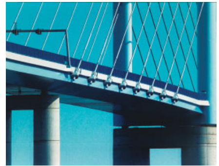
Ziegelgrabenbrücke: Die Fahrbahn wird zum Pylon harfenförmig mit jeweils zwei außenliegenden Seilebenen aus 8 parallelen Seilen abgespannt.
