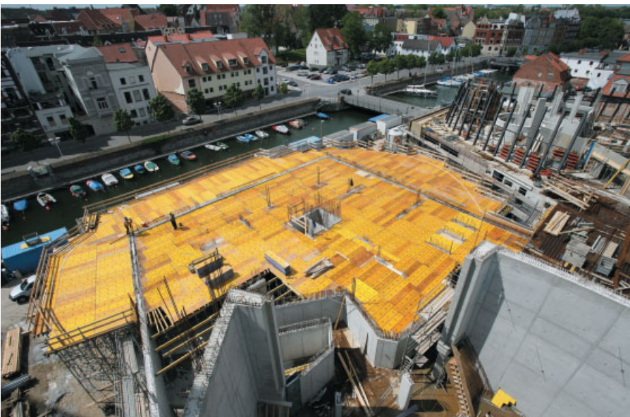
Schalung der „Tischplatte“ des Baukörpers „Nordsee“
