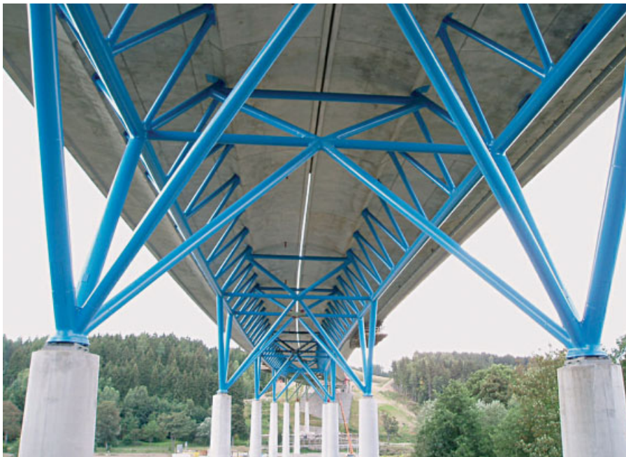
Über den Betonpfeilern gabeln sich die Fachwerkstäbe wie bei einer Baumkrone
