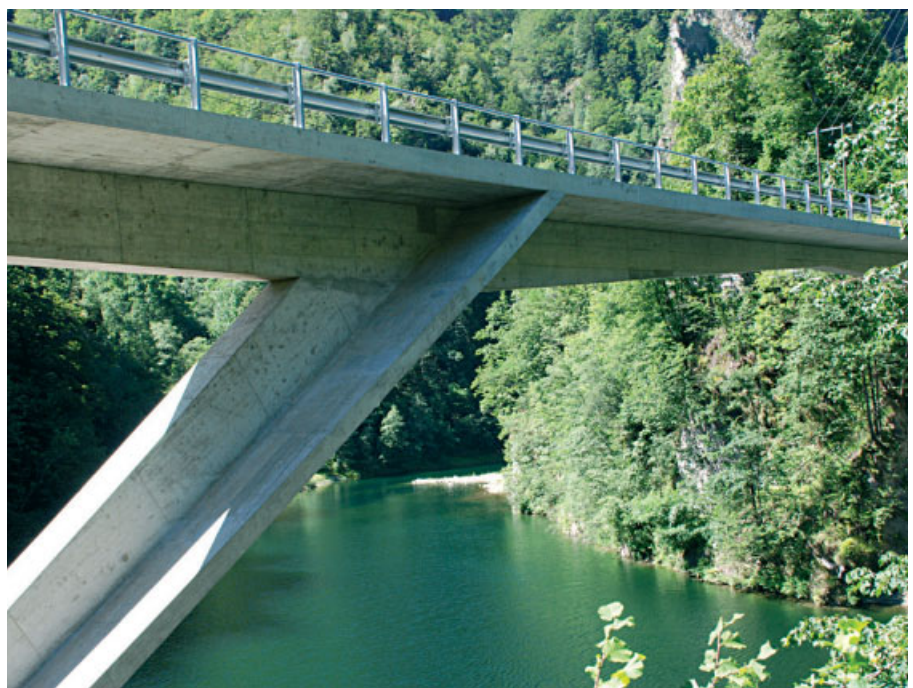
Der Pfeilerflansch stabilisiert gegen seitliches Knicken und blockiert die Torsion des Hauptträgers
