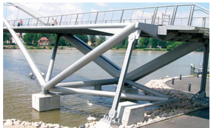
Bogenfußpunkte an den Ufern, um die Schifffahrtsöffnung freizuhalten
