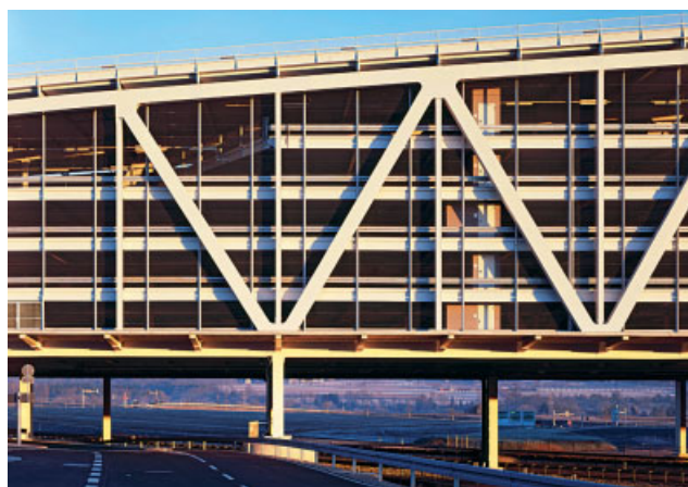
Alle Verbindungen biegesteif – keine Lager
