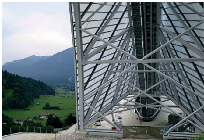
Drucklager nahe am Schwerpunkt der Anlaufkonstruktion: wirtschaftliche Ableitung der Kräfte
