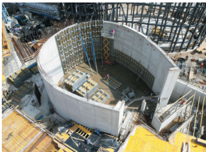
Fertige Betonschale des 10 Meter tiefen Schwarmfischbeckens der Nordsee Hinten: räumliches Stabwerk der „Riesen der Meere“
