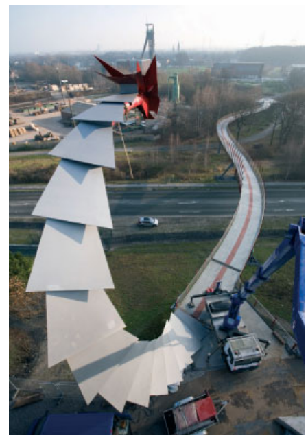
180°-Verdrehung des Drachenhalses – eine Herausforderung für den Stahlbau
