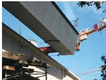
BAB A45 Talbrücke Windelbach
