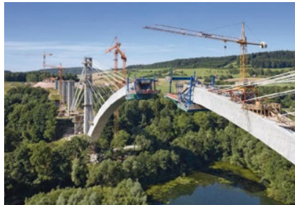
ICE Neubaustrecke Talbrücke Froschgrundsee
