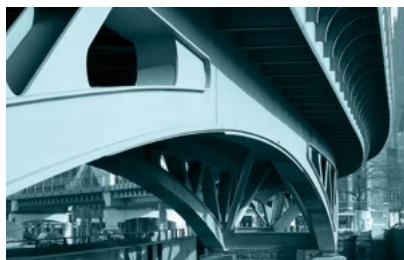
Stahlviadukt Binnenhafenbrücke, Hamburg
