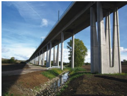
ICE Neubaustrecke Gänsebachtalbrücke
