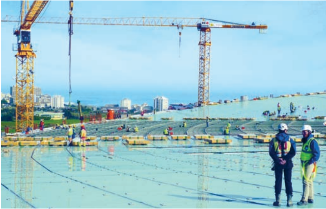
Bild 4. Montage von Seiltragwerk und Glasdach (Fotos: PFEIFER)
